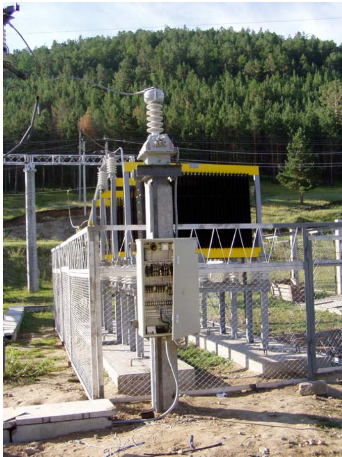
Рис. 7 Резистор РЗ-4000-102-35 на ПС Еланцы
