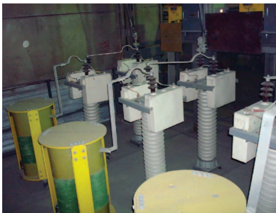
Рис. 4. Общий вид RC-цепи в сети 110 кВ
