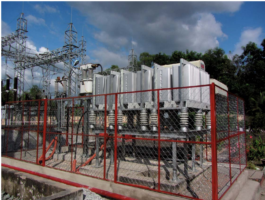
Рис. 5. Общий вид резистора сопротивлением 10 Ом в четырёхпроводной сети 22 кВ ПС «Binh An»
