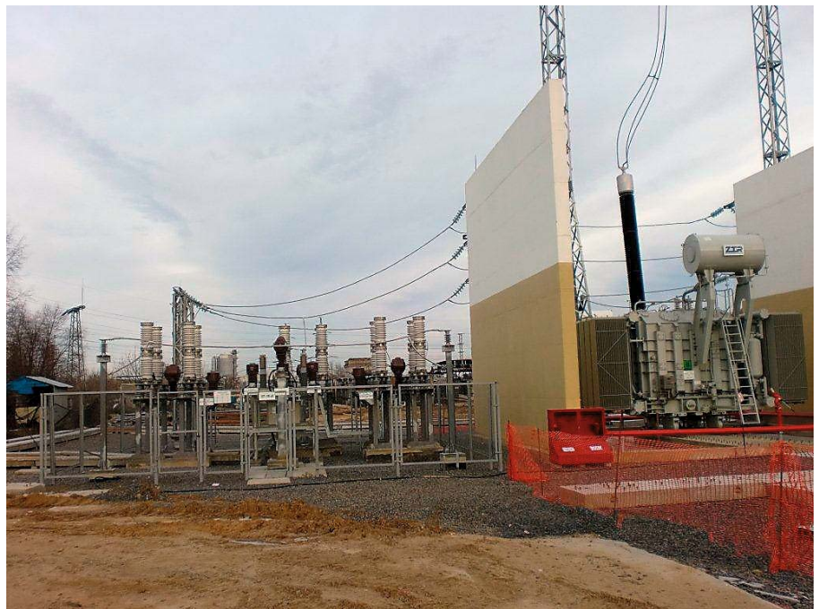
Рис. 2. Общий вид резисторной установки в цепи ШПР на ПС 500 кВ «Очаково»
