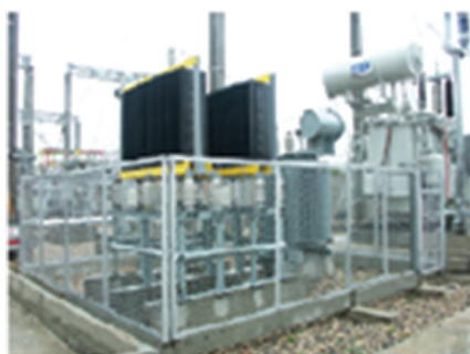
Резисторы типа P3 производства ООО «Болид» в действующих электрических сетях
