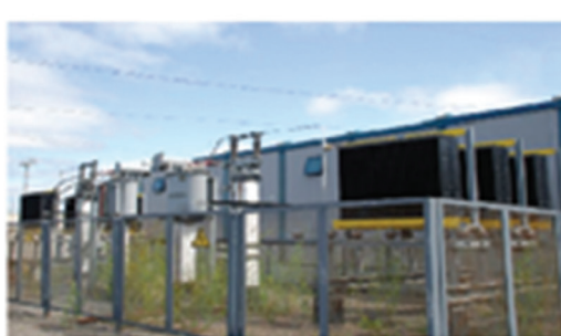
Резисторы типа P3 производства ООО «Болид» в действующих электрических сетях
