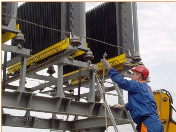
Проектирование и строительство
