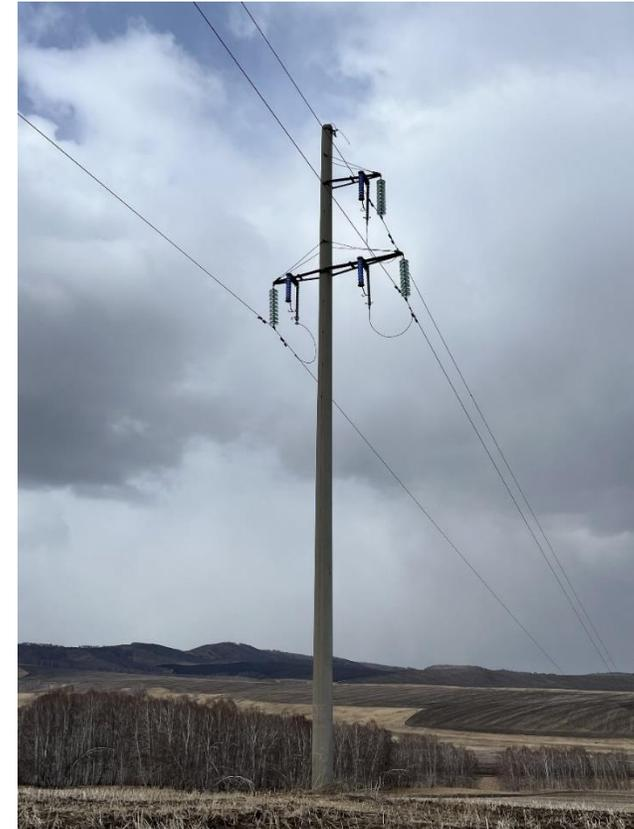
Зафиксировано срабатывание РМКЗ, предотвратившее грозное отключение линии, что подтверждают данные регистраторов токов молнии от 08.07.2023 - удар молнии в фазный провод между опорами № 287 и 288. Опытно-промышленная эксплуатация признана успешной.
