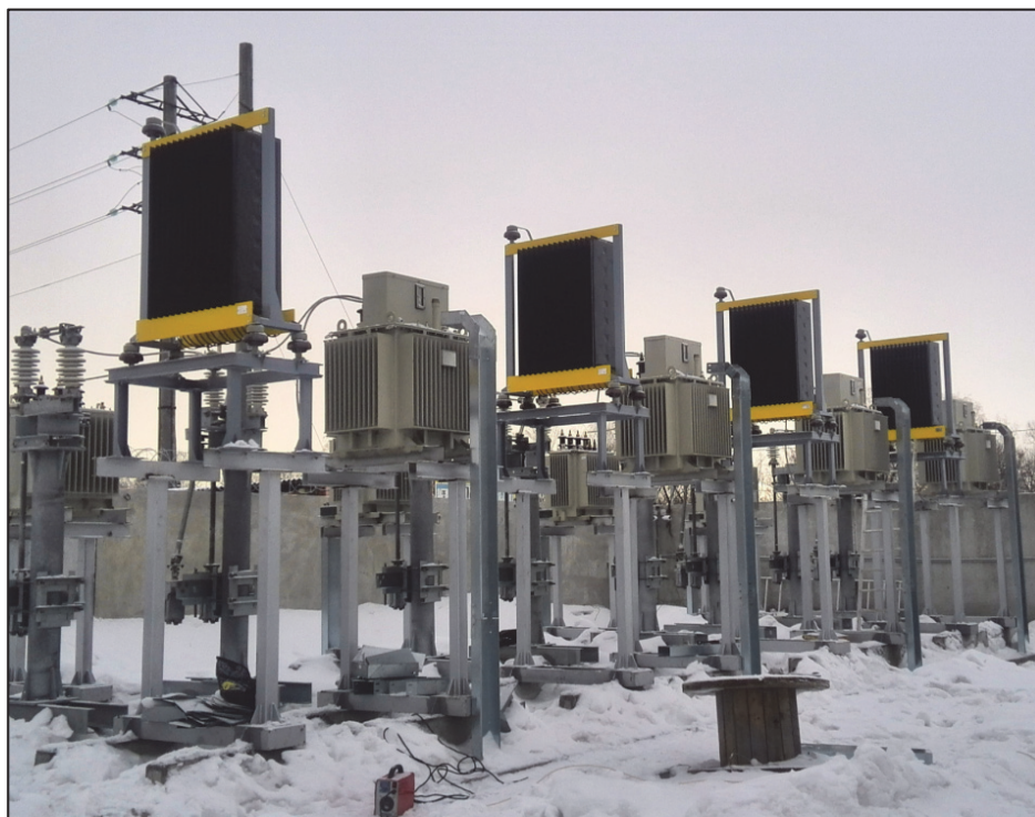
Рис. 10. Установка высокоомных резисторов 1000 Ом/10 кВ/ длительной работы параллельно плунжерным ДГР 500 кВА с автоматическим управлением в нейтрали отдельных присоединительных трансформаторов 630 кВА
