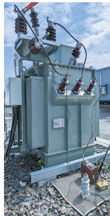
Рис. 3. Схема подключения измерительной аппаратуры при измерениях в сети 10 кВ (а) и внешний вид масляного дугогасящего агрегата с трансформатором тока в цепи искусственного замыкания и делителем напряжения в нейтрали (б)
